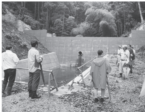
豪雨時に流水被害のあつた地点の上流にある砂防ダムを確認
